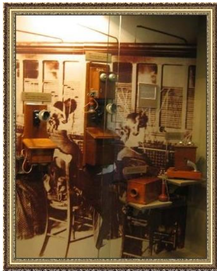
На телефонной станции. Начало XX века
