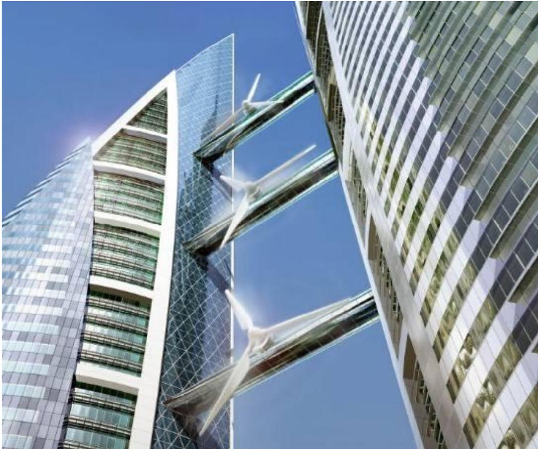
Две башни высотой 240 м. соединены тремя мостами, держащими по одному 225 КВт ветрогенератору, производящими от 11 до 15 % э/энергии необходимой зданию. Ветрогенераторы ориентированы на самый сильный и постоянный ветропоток. Башни, в плане, спроектированы в форме туннеля, ветер, проходя через брешь, обеспечивает ускорение ветрового потока.
