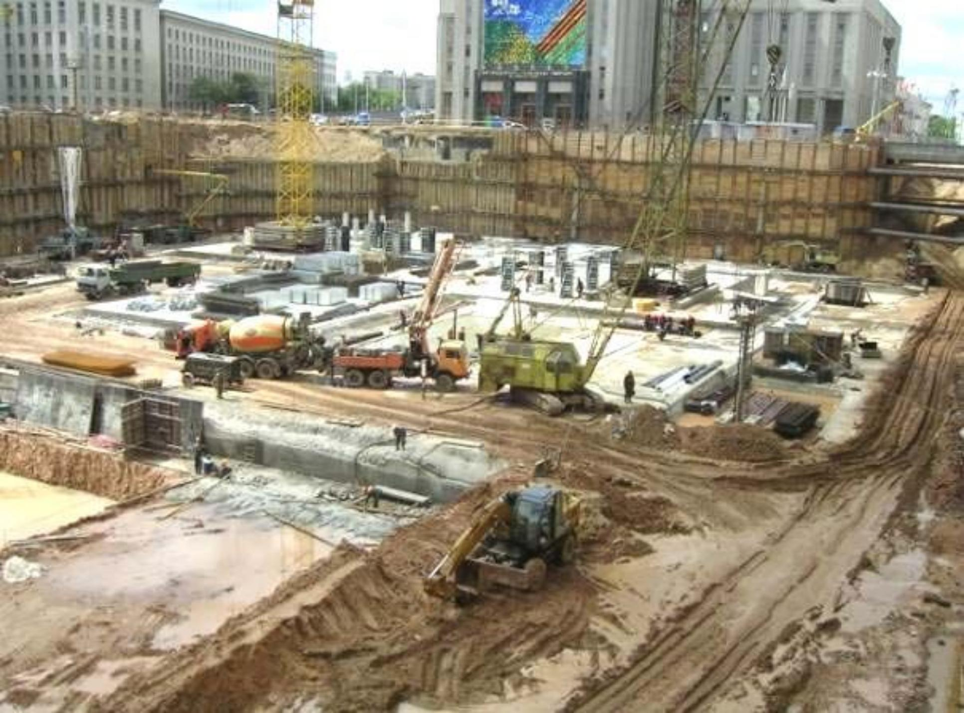
Применяется при глубине заложения сооружения до 18 метров;
