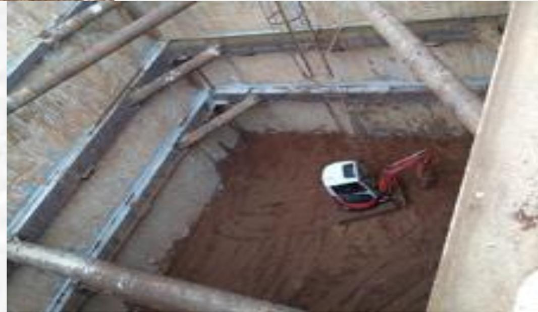
**Разработка грунта внутри объекта. Монолитная стена временно закреплена извлекаемыми обвязочным поясом из металлопроката и распорами из труб**
