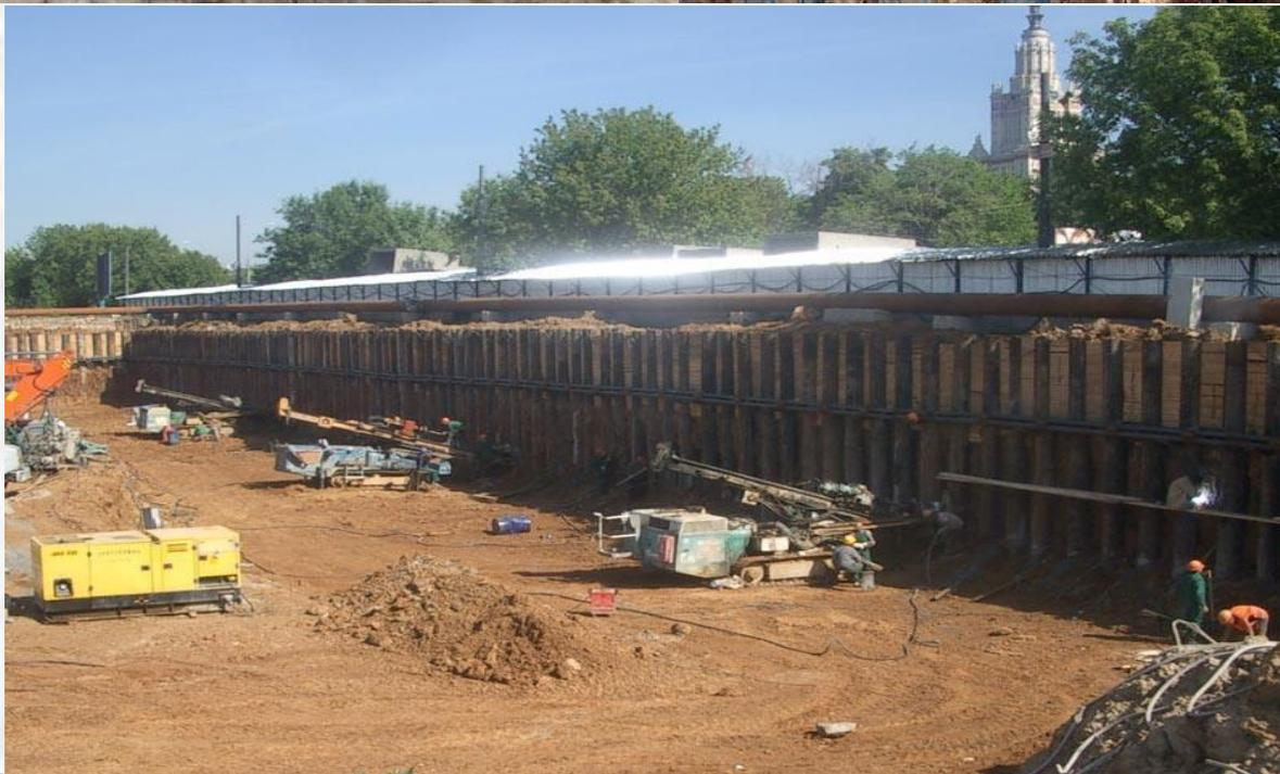
**Установка анкерного крепления стенок котлована**
