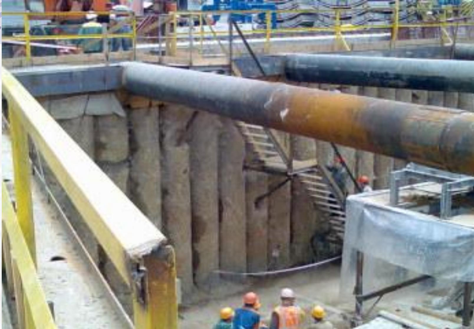
**Постоянное закрепление стенок котлована касательными сваями с извлекаемыми обвязочным поясом из металлопроката и поперечными распорами**
