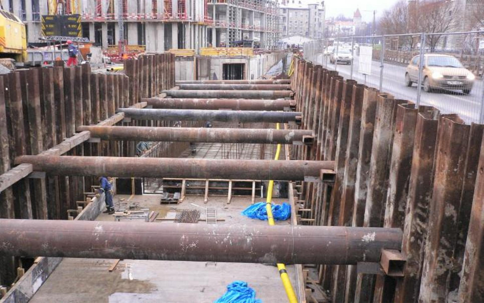
**Извлекаемое закрепление стенок траншеи из стального профиля, с
