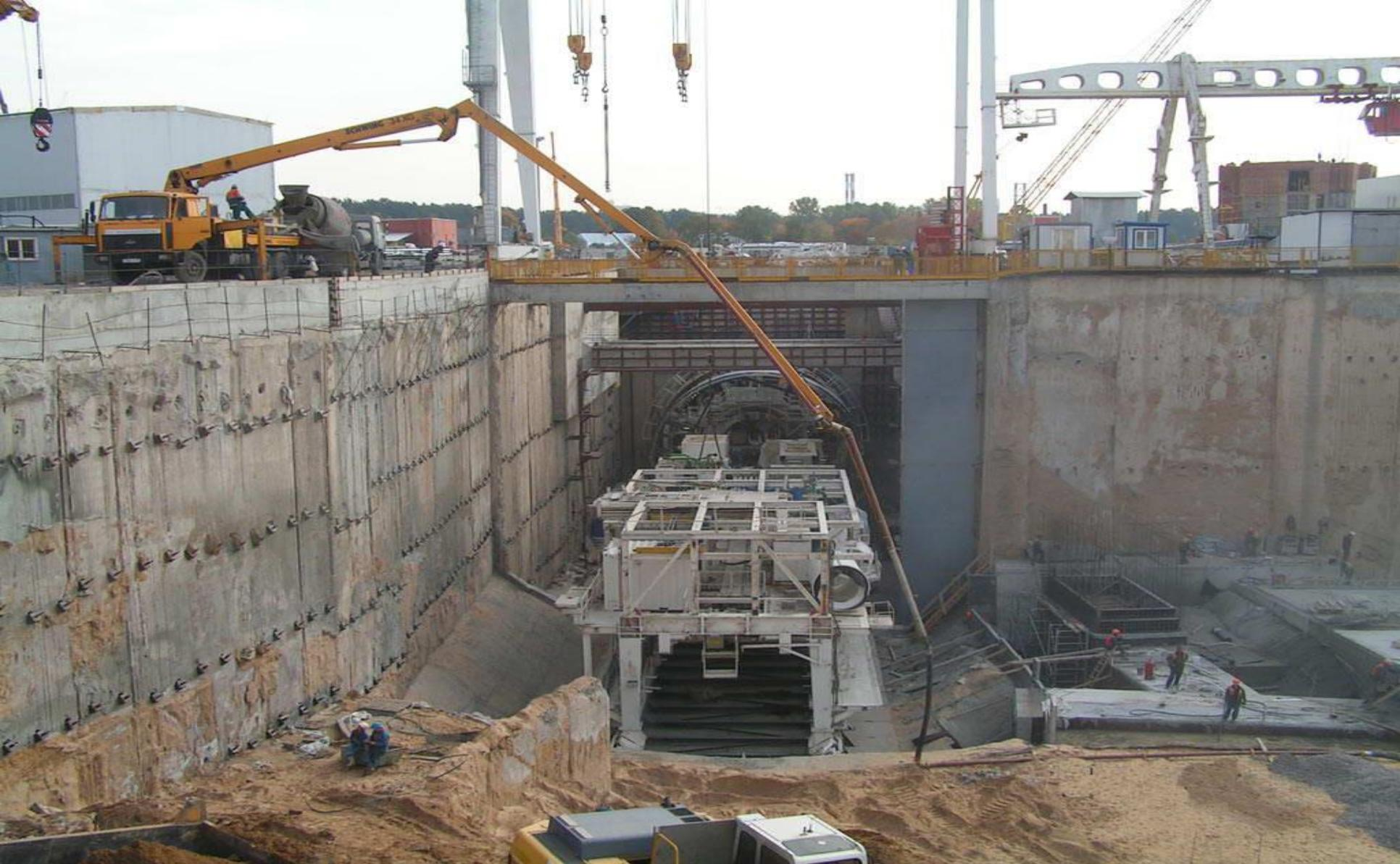
**Возведение внутренней части объекта. Монолитная стена закреплена анкерами.**
