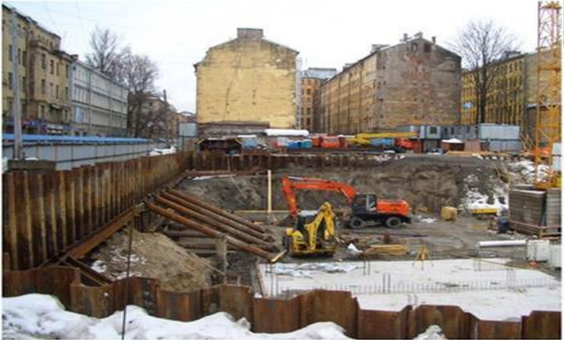
**Извлекаемое закрепление стенок котлована из шпунта Ларсена, с
