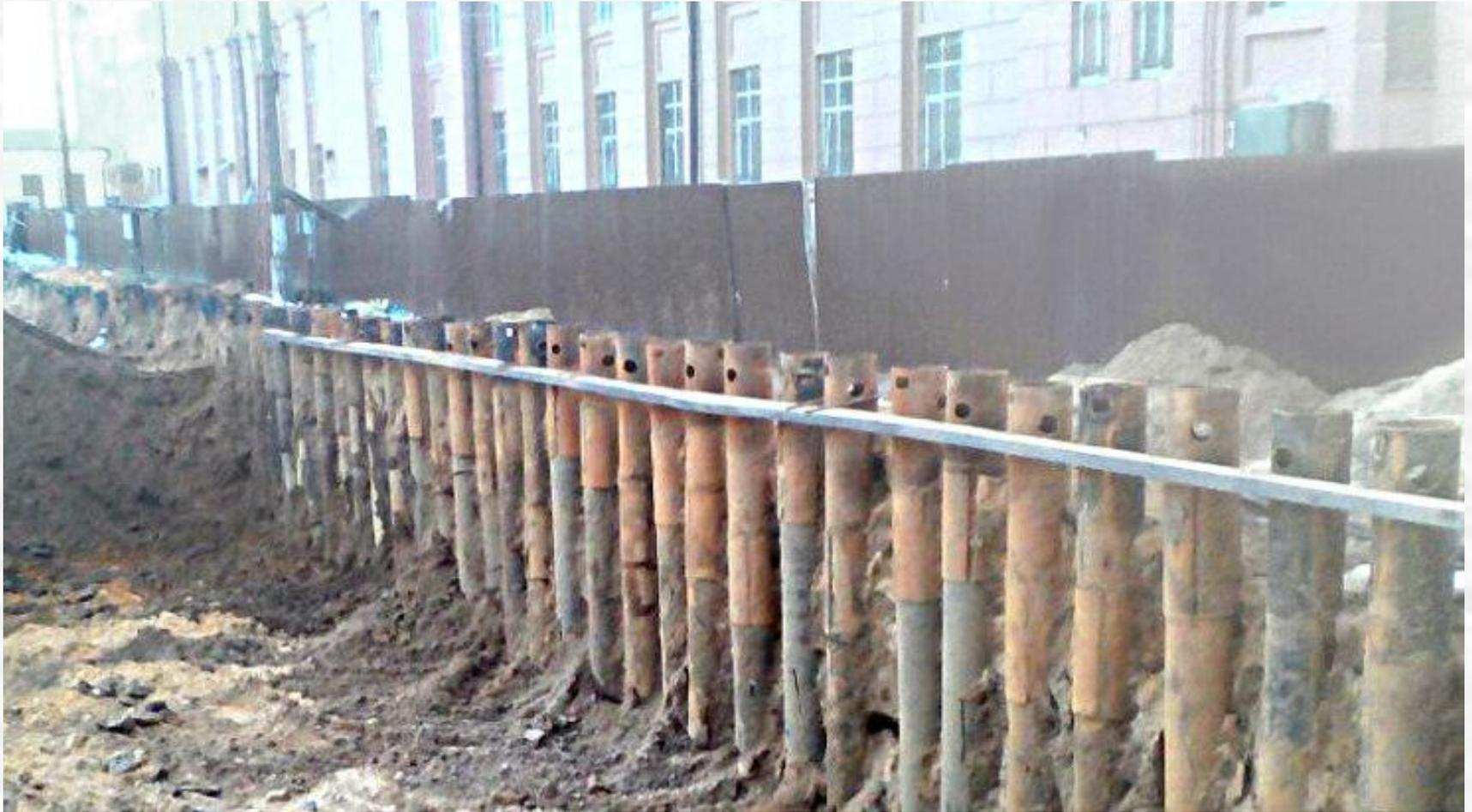
**Извлекаемое закрепление стенок выемки из труб с обвязочным поясом из металлопроката**
