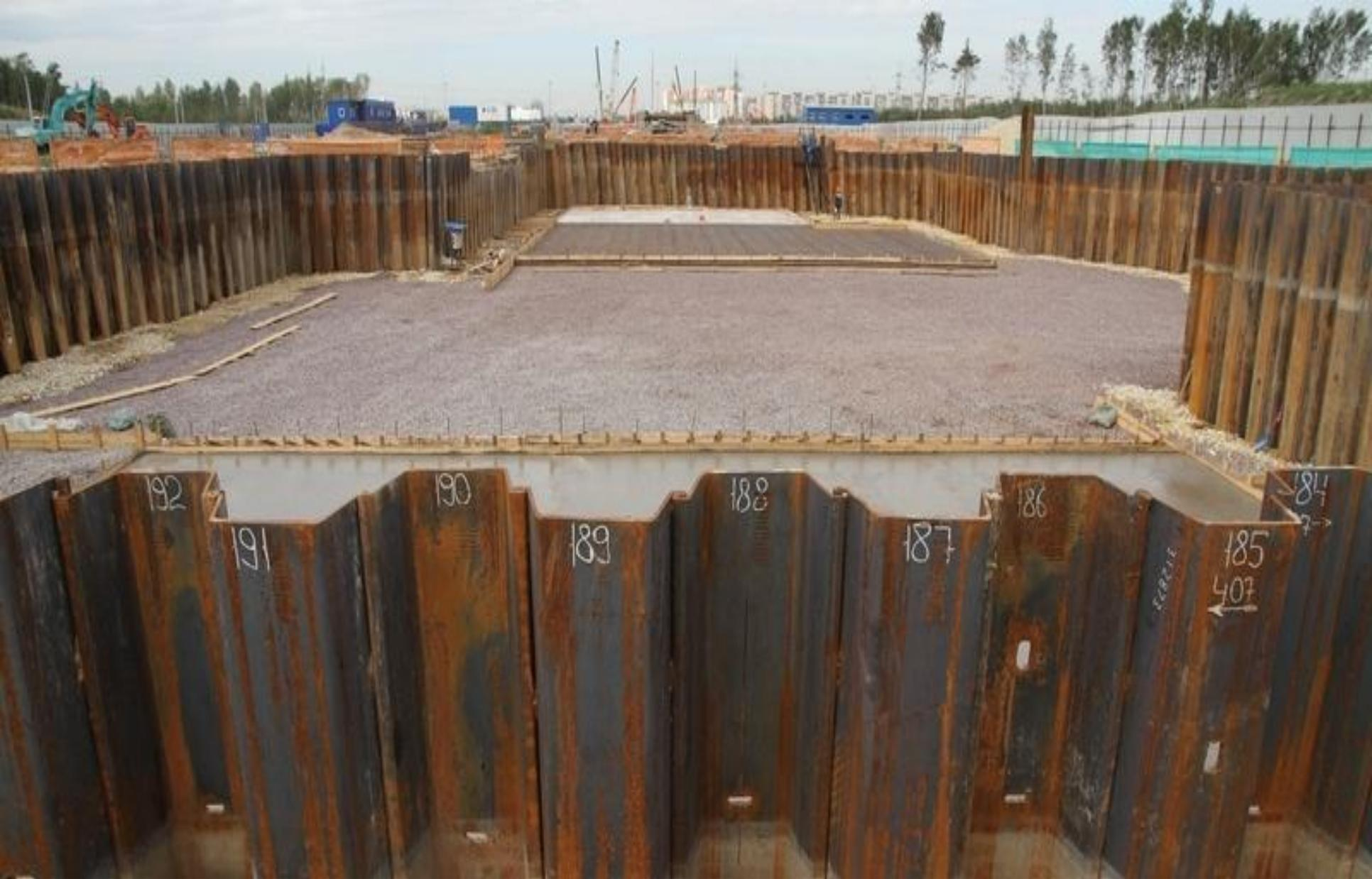
**Извлекаемое закрепление стенок котлована из шпунта Ларсена**
