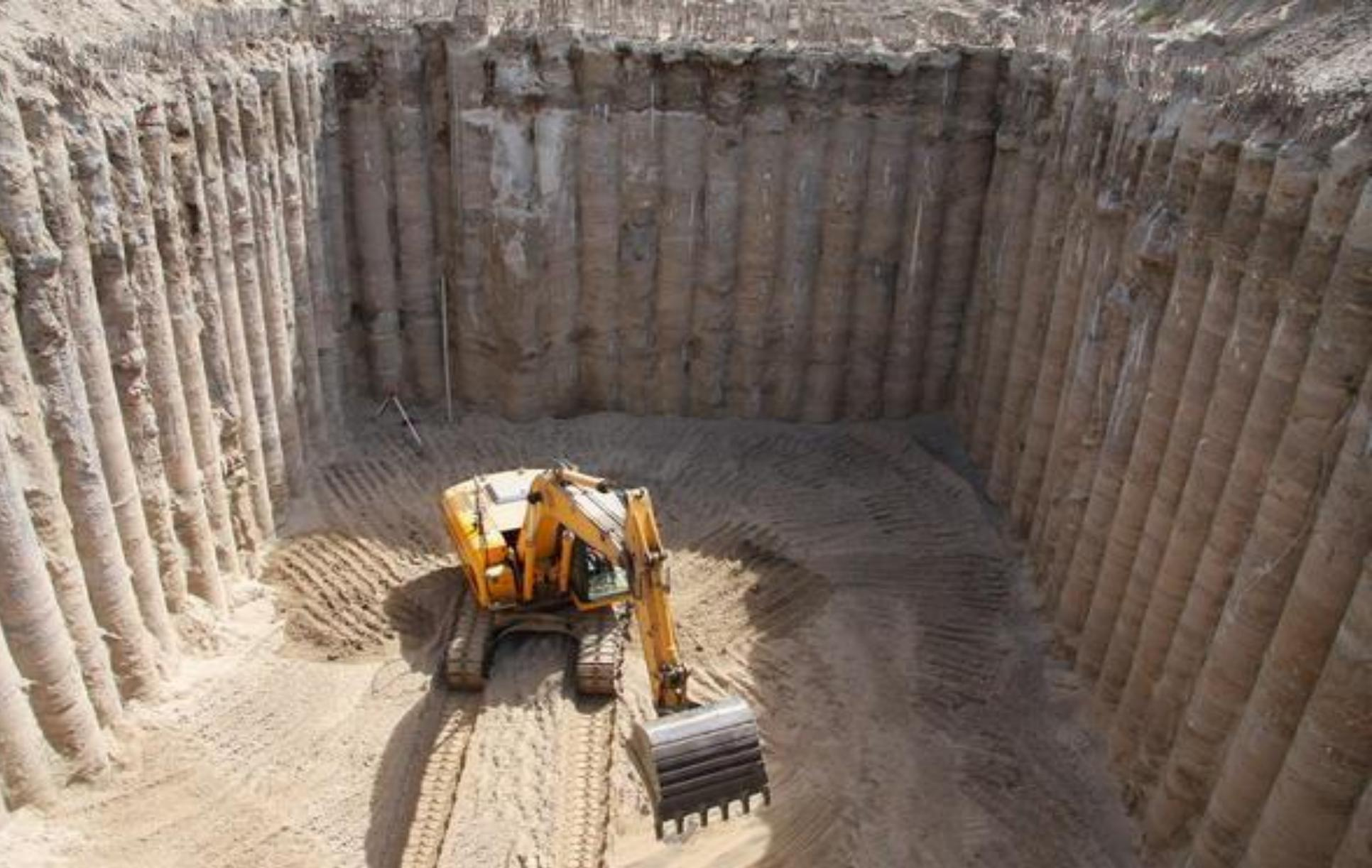
**Постоянное закрепление стенок котлована касательными сваями**
