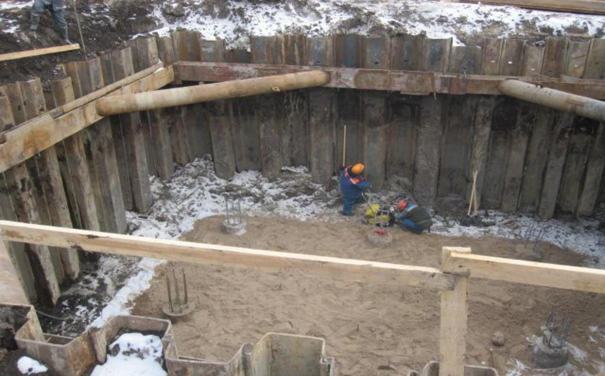
**Извлекаемое закрепление стенок котлована из шпунта Ларсена, с обвязочным поясом из металлопроката и угловых распоров**
