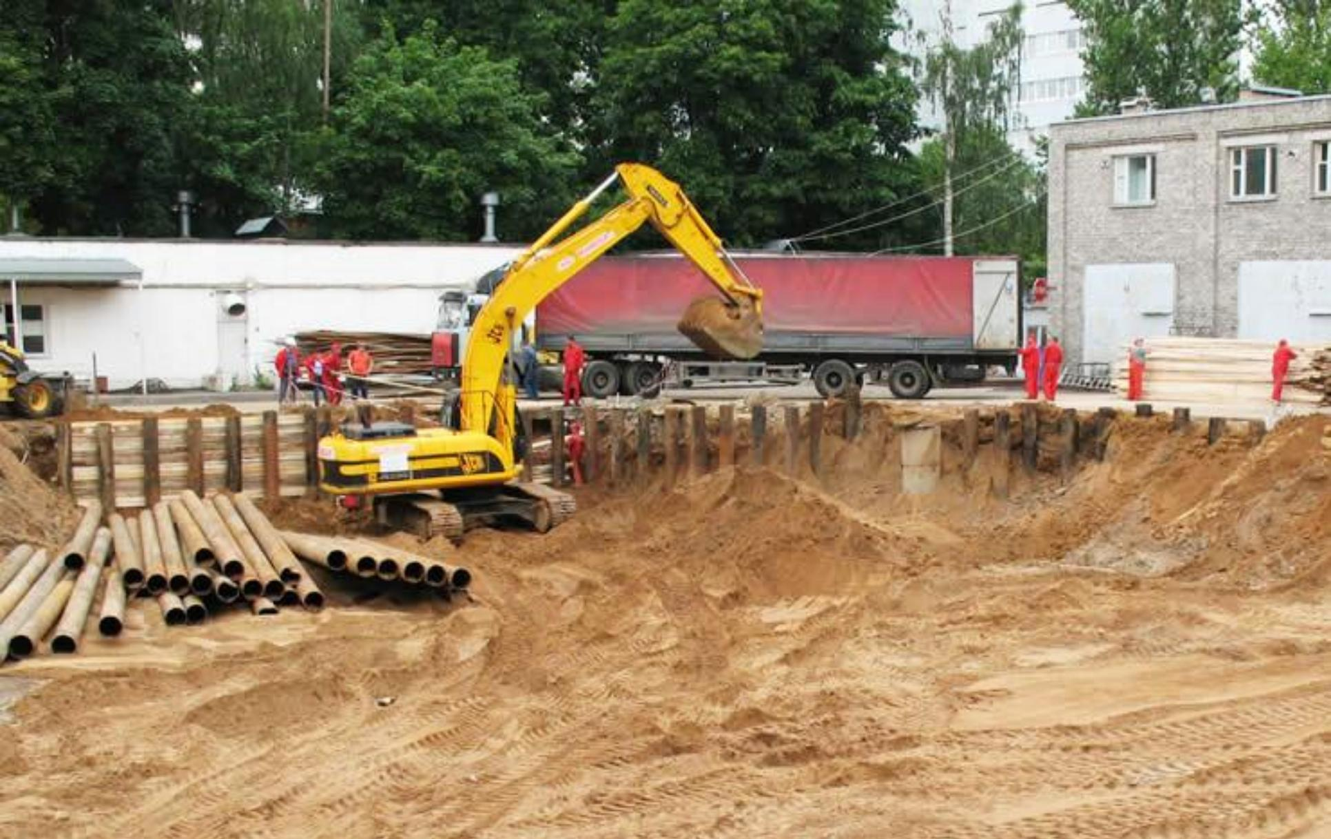
**Частично извлекаемое закрепление вертикальных стенок котлована шпунтами из труб, установка забирки параллельным потоком**
