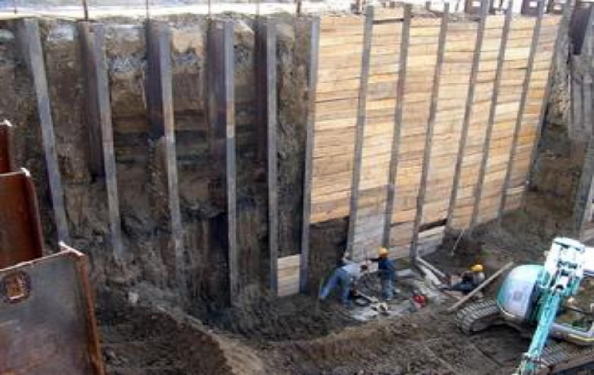
**Частично извлекаемое закрепление вертикальных стенок котлована шпунтами из двутавра, установка забирки отдельным потоком**
