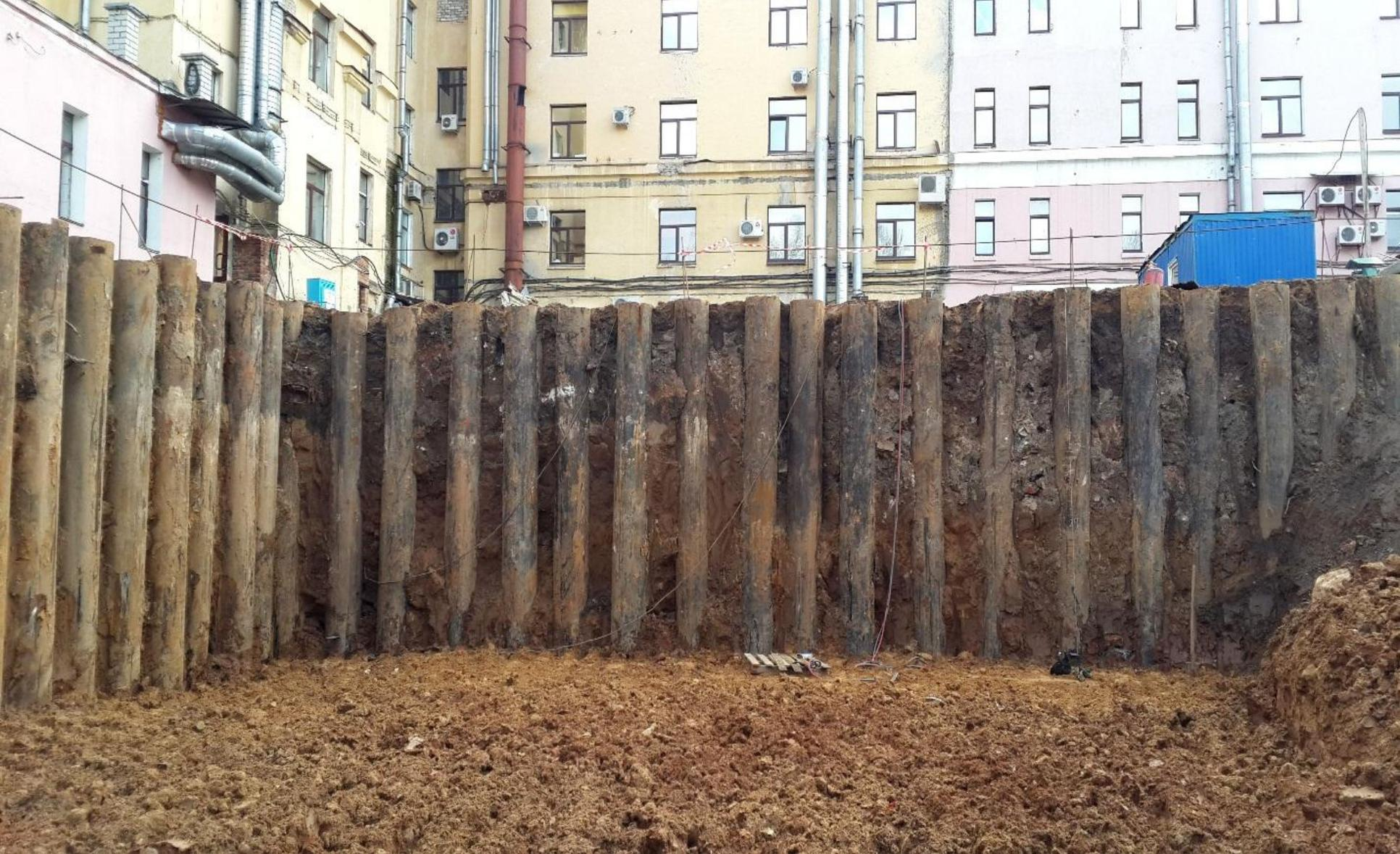
**Постоянное закрепление стенок котлована прерывистыми сваями**
