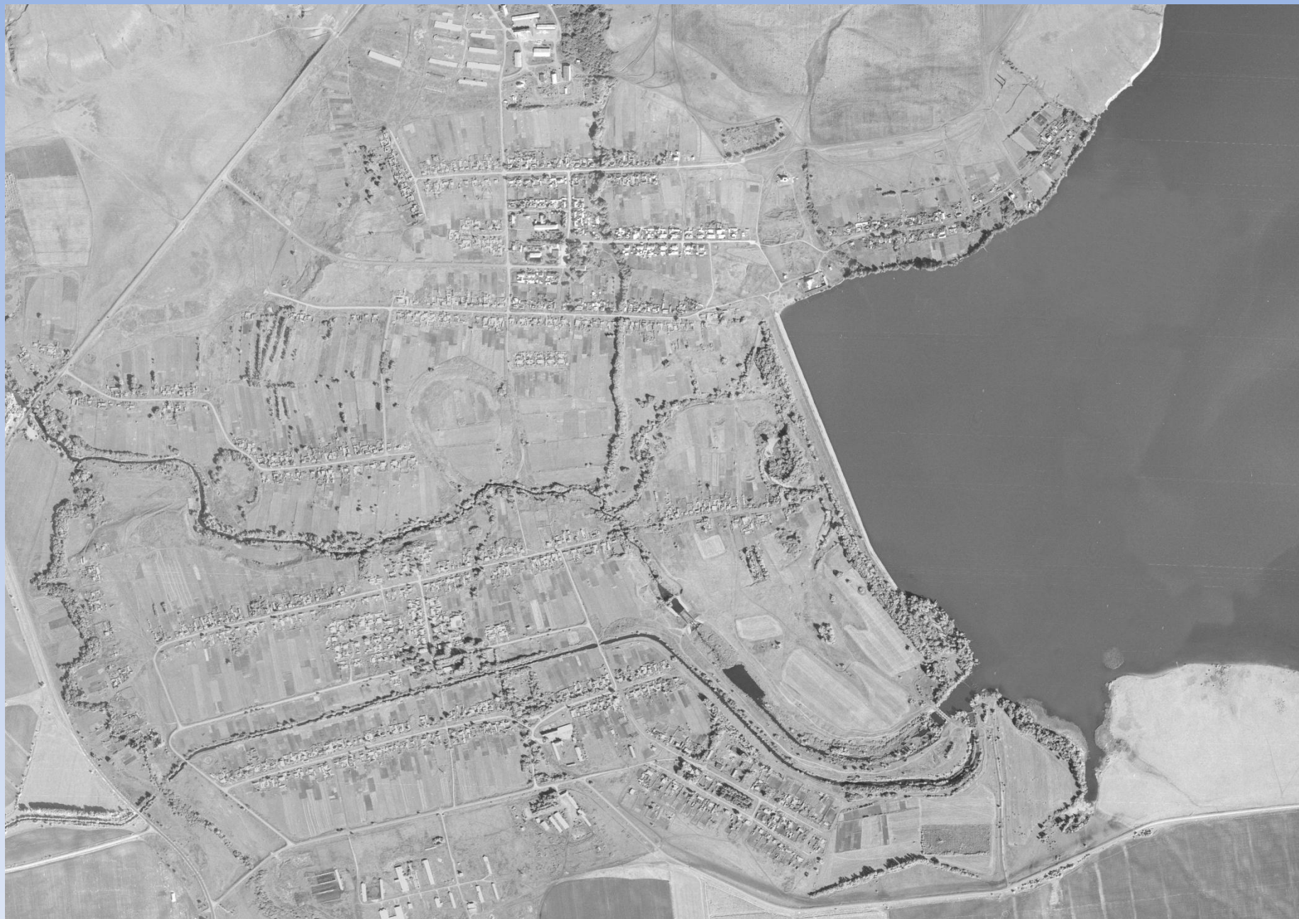
Рис. 3 Аэрофотоплан расположения плотины Кутулукского водохранилища
