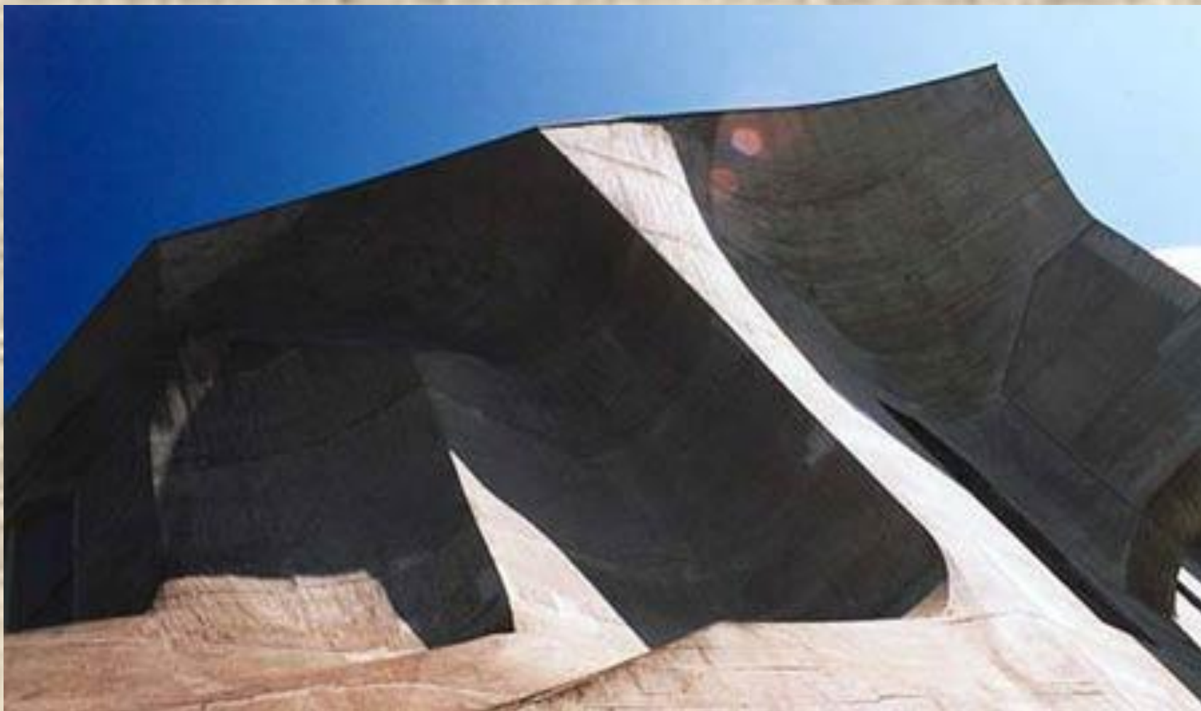
Здание Второго Гётеанума. Дорнах. Швейцария.
