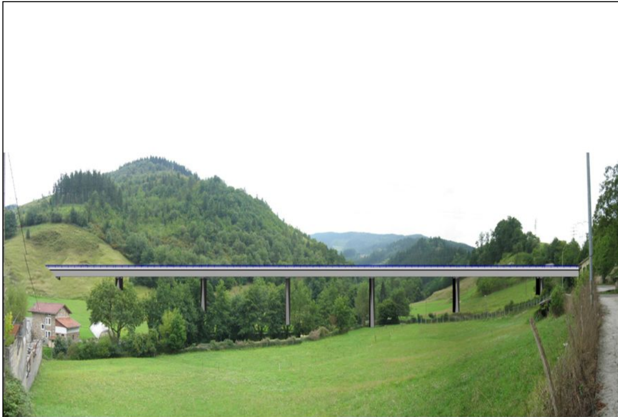
VIADUCTO DE LEGINETXE
