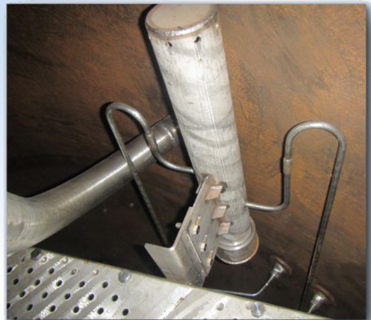
Датчик оперативного контроля уровнемеров
