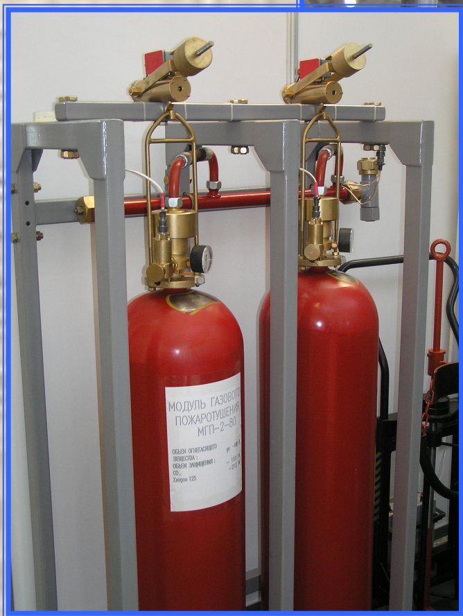
Модуль газового пожежогасіння МГП-2-80 (Харківський механічний завод)
