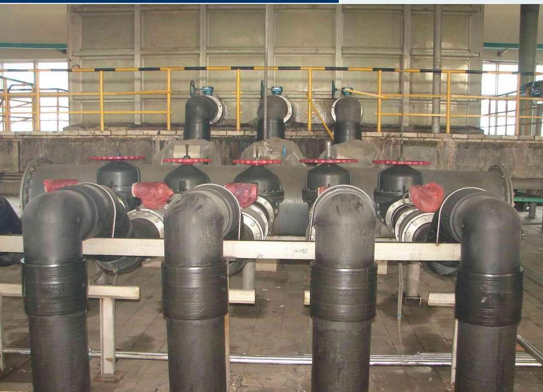
Трубопровод для перевозки раствора медного купороса и 20% из разбавленной серной кислоты в провинции Шанидун.
