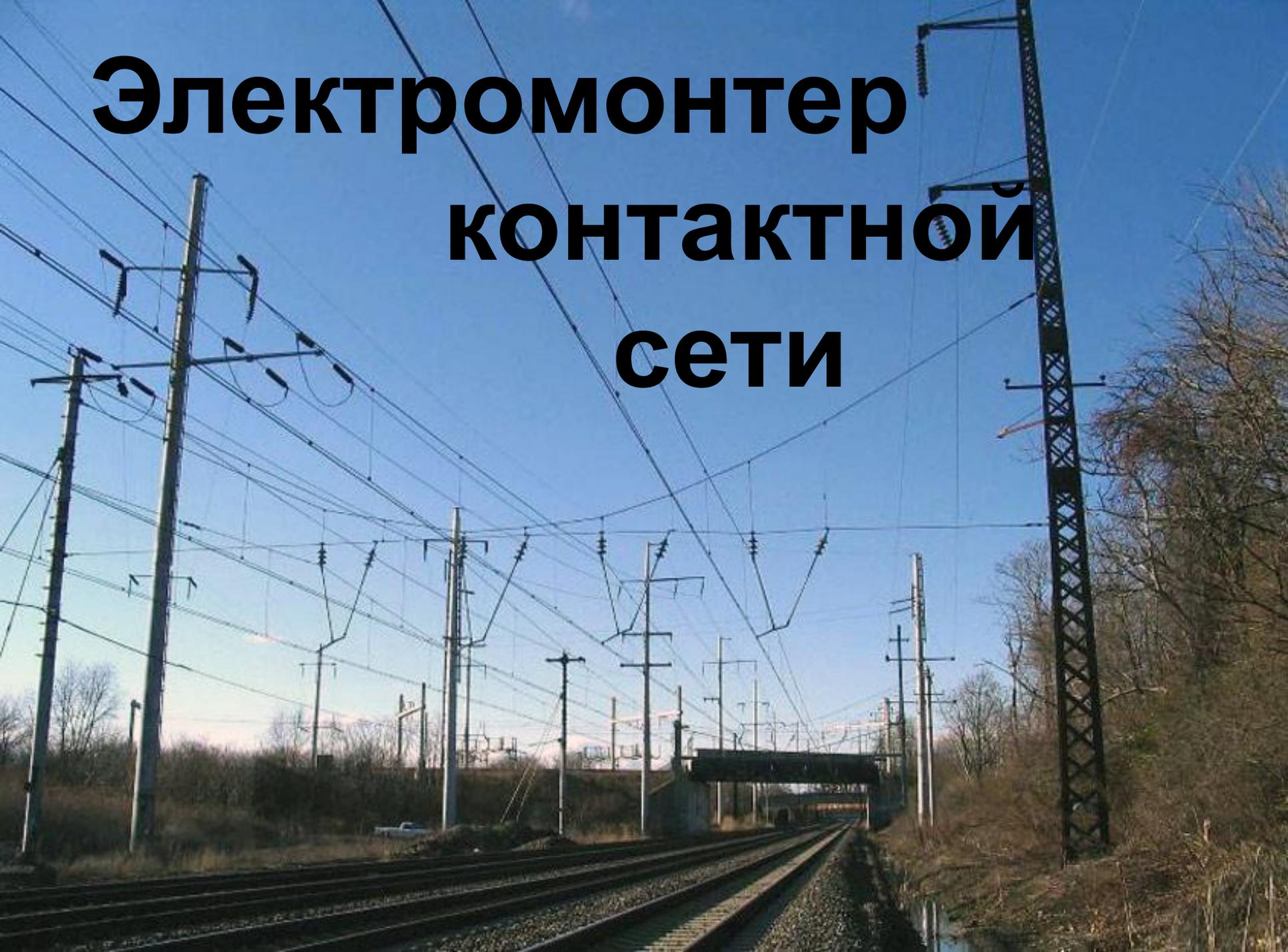
**Контактная сеть** — комплекс устройств для передачи электроэнергии от тяговых подстанций к ЭПС через токоприёмники.
