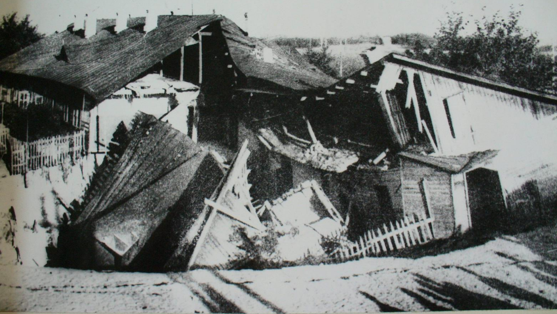
Провал барака в пос. им. Калинина ( 6.08.59г.Диаметр 25,0 м )
