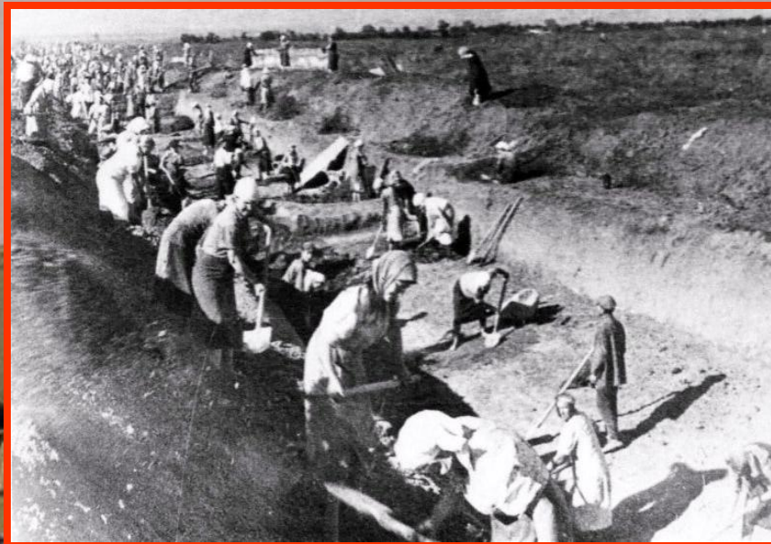
Жители Сталинграда на строительстве противотанковых рвов.
