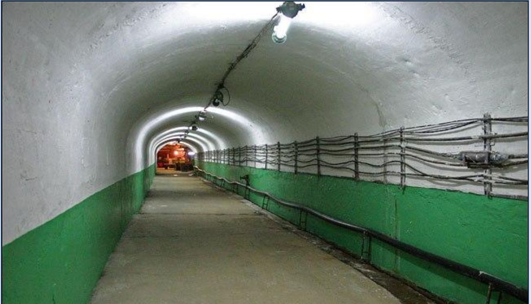
Нейтринная Баксанская станция
