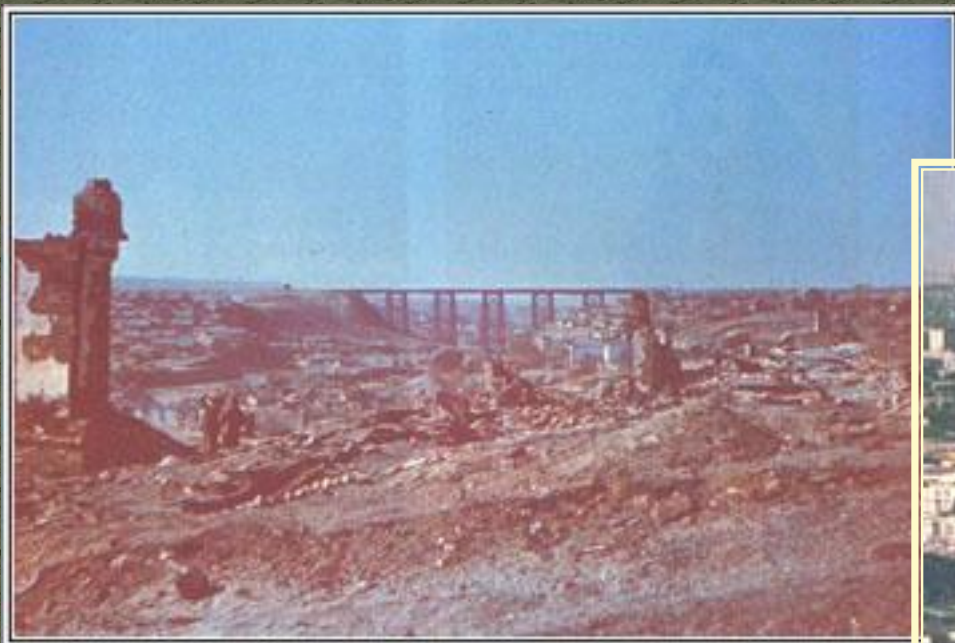
Разрушения в Сталинграде, октябрь 1942г.
