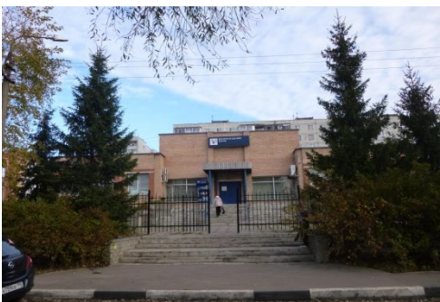
ЗДАНИЕ И ФАСАД
