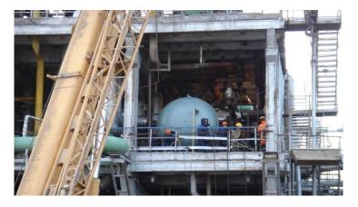
ДЛЯ СНИЖЕНИЯ ПРОИЗВЕДЕНА ЗАМЕНА АБСОРБЕРОВ ПОЗ. 2A6/1, 2A6/2, 1A6/1 ДЛЯ АБСОРБЦИИ ГАЗООБРАЗ-НОГО АММИАКА.
