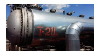
ПЕРЕД СБРОСОМ В ХЗК (ИФ-6) УСТАНОВЛЕН ДОПОЛНИТЕЛЬНЫЙ ТЕПЛООБМЕННИК Т-211/2
