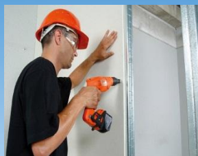
Мастер «сухого» строительства
