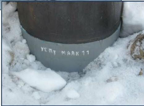
В 2011-2014 гг. ОАО «Фундаментпроект» и ЗАО ПРО ВНИИГА провел лабораторные и натурные опытные испытания на месторождении Медвежье (ООО «Газпром добыча Надым», ЯНАО) свай СМОТ с применением прошивки предела **50-60 %**, подтверждение эквивалентности ОСПТ каменным характеристикам. Результат - снижение касательных сил материала.
