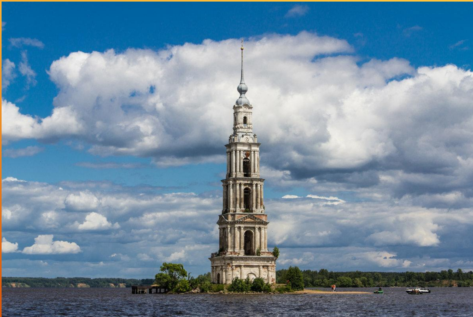
Колокольня Никольского собора. Г. Калязин
