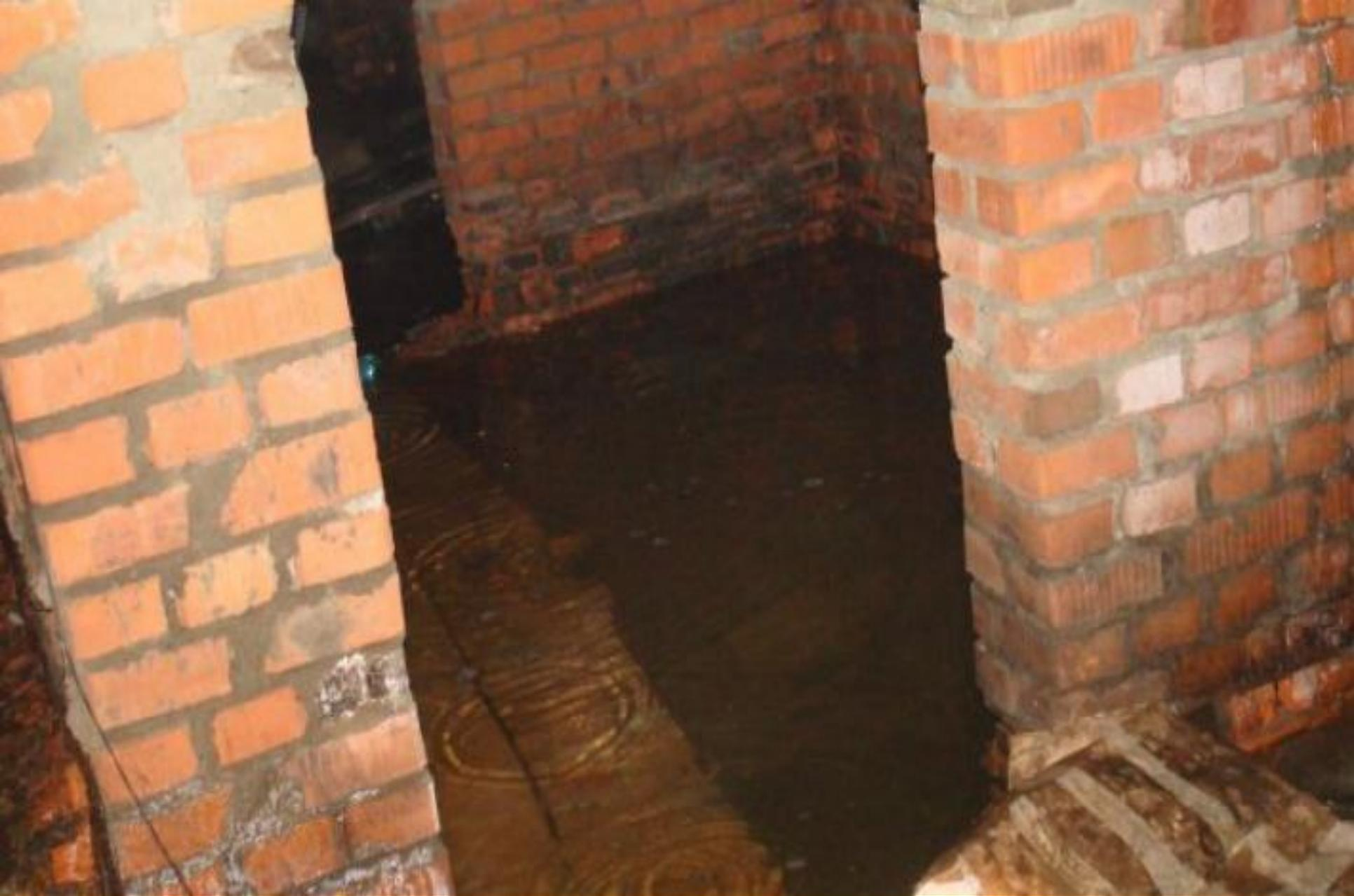
Рисунок 4 Затопление подвала
