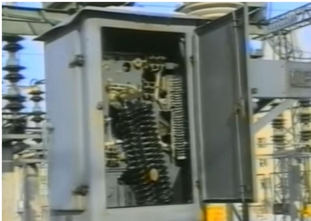
Маломаслянные выключатели просты и надёжны в конструкции, они имеют высокую заводскую готовность и доступ к контролируемым элементам, контактам, камерам, которые требуют минимальный объем работ при их замене. Выключатели управляются пружинными приводами ППРК.
