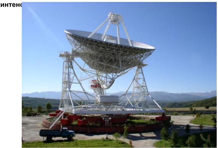
Радиоинтерферометр — инструмент для радиоастрономических наблюдений с высоким угловым разрешением, который состоит, как минимум, из двух антенн, разнесённых на расстоянии и связанных между собой кабельной линией связи.
