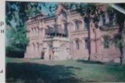
Парадный вход во дворец с балконом, ограждение которого изготовлено из кузнечного литья причудливой формы.
