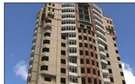
Возведение наружных стен из особо легкого ( \gamma_L = 250 \text{ кг/м}^3 ) полистиробетона на композиционных шламовых вяжущих с обшивкой в кирпичной кладкой 1/2 к. с гибкими базальтопластиковыми связями (патенты № 216913 и № 217105, жилые здания в мкр. Курино, г. Москва)
