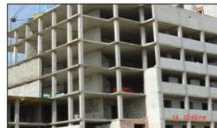
Возведение монолитного каркаса из легких бетонов классов до В45 экл. с \gamma_L = 1800 \text{ кг/м}^3 на основе шламостеклогранулита НЛМК (патент на полезную модель № 35119, возведение жилых зданий в г. Воронеж)
