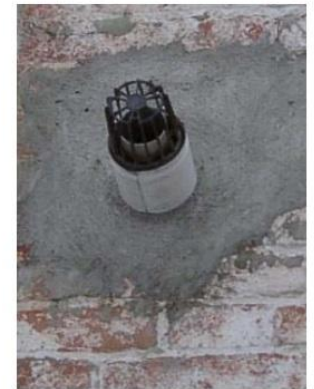
Рис. Выброс дымовых газов через стену, без установки коллективного дымохода запрещен
