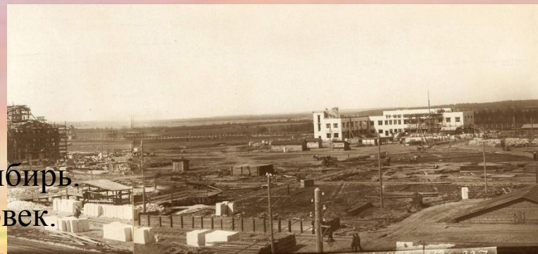
Строительство Горьковского автозавода, 1930 год
