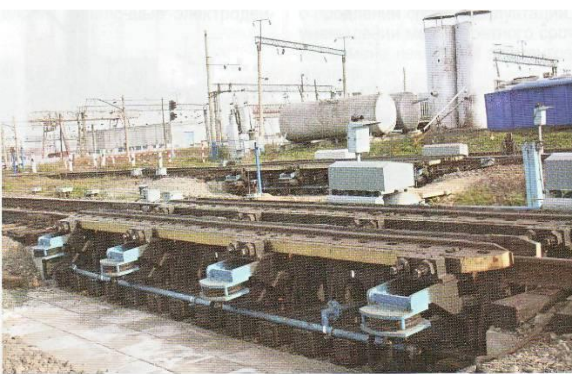
Замедлитель КНЗ-3пк, установленный на первой тормозной позиции четной горки станции Тайшет
