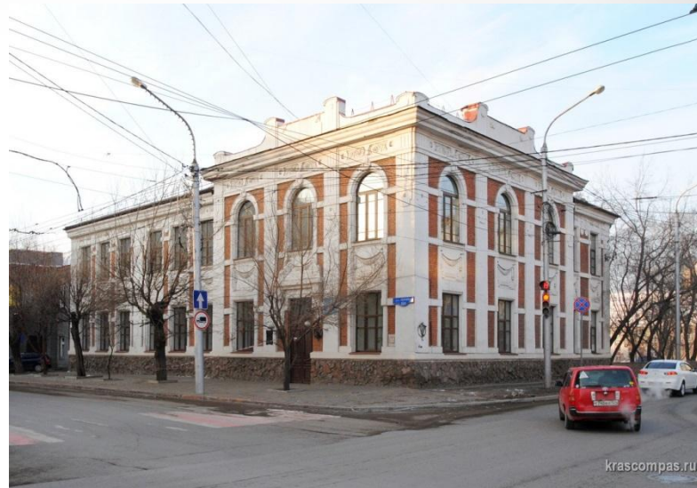
Здание Начального училища Красноярск 1911 год.
