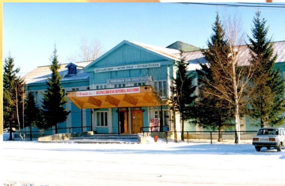
Здание Междуреченского районного Дома культуры. 2002 год
