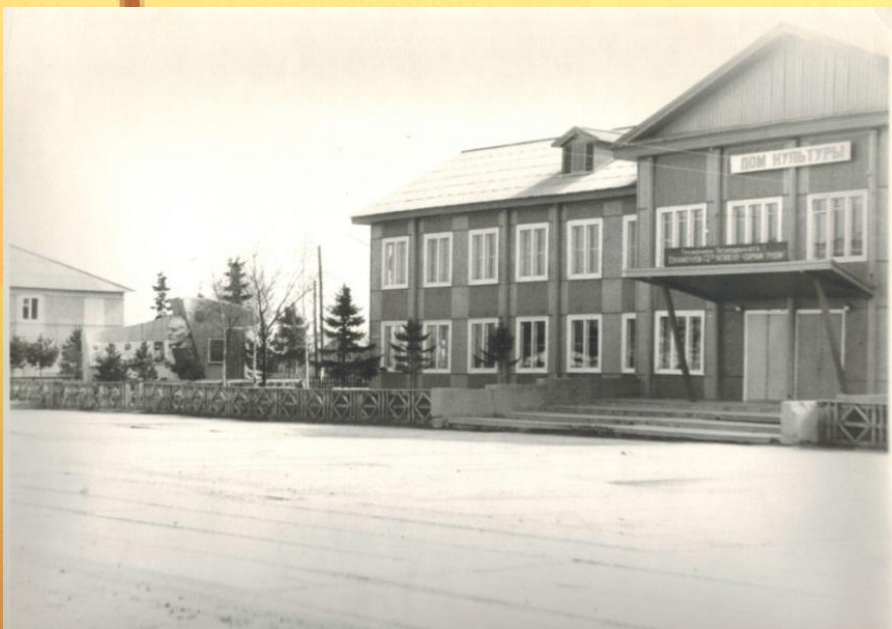
Здание Междуреченского Дома культуры по ул. Титова, д. 15. 1980-е.
