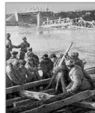
Саперы 2-го Украинского фронта наводит мост через пограничную реку Прут (Апрель 1944 г.).
