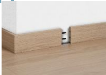
Соединение 2 палок плинтуса
