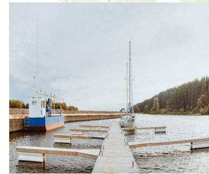
Обустройство гавани яхт-клуба, строительство набережных
