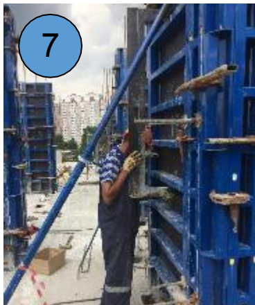
4 Выставление опалубки обязательно контролируется уровнем
