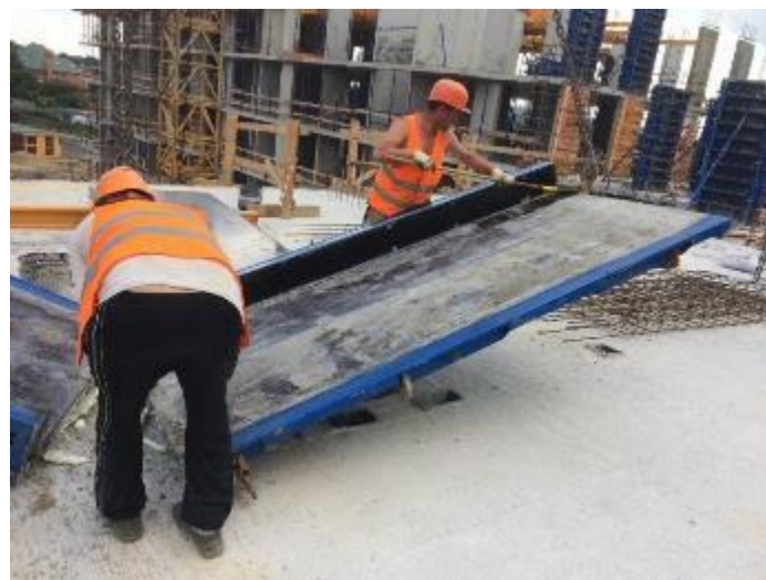
Подготовка опалубки к последующему монтажу (чистка)
