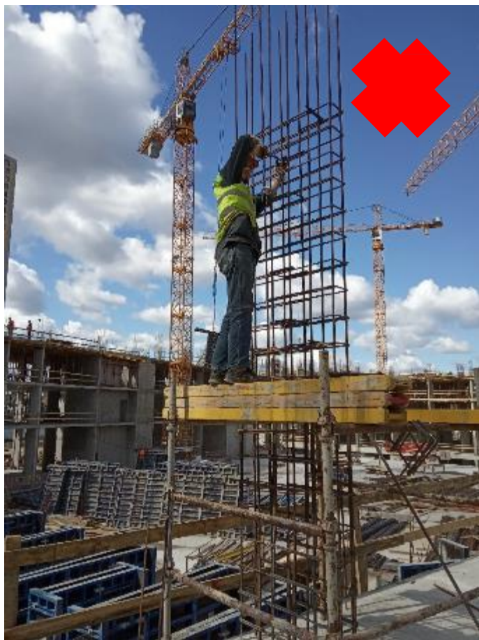
Каркасы пилонов вяжут на монтажном горизонте.
