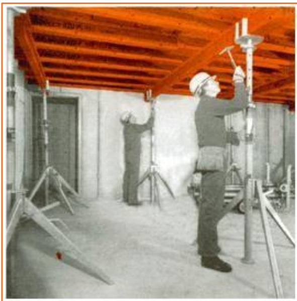
Опускание продольной балки
