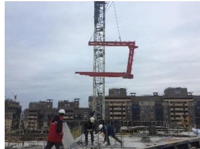
Даже при отсутствии разбираемых «столов» время цикла и расход фанеры сокращается
