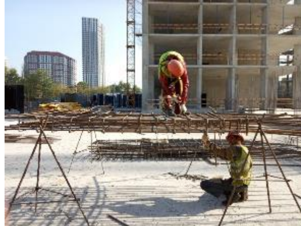
Каркасы на пилоны вяжут в арматурном цехе и подают на
