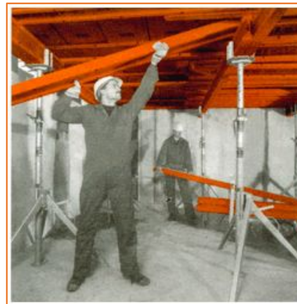
Снятие поперечной балки
