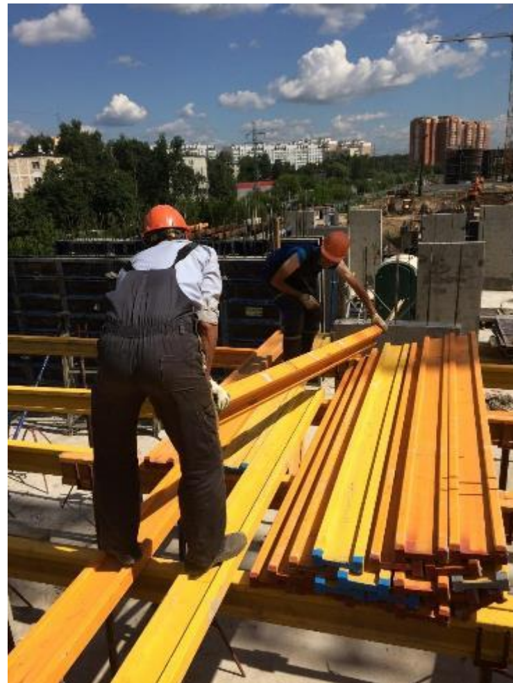
Установка поперечных балок и выверка продольных балок по высоте
