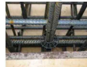
Применение фиксаторов для получения защитного слоя
