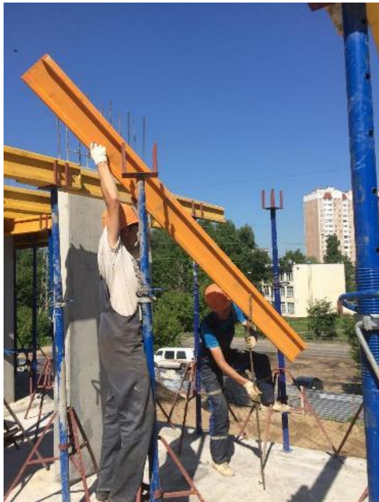
Укладка продольный балок
