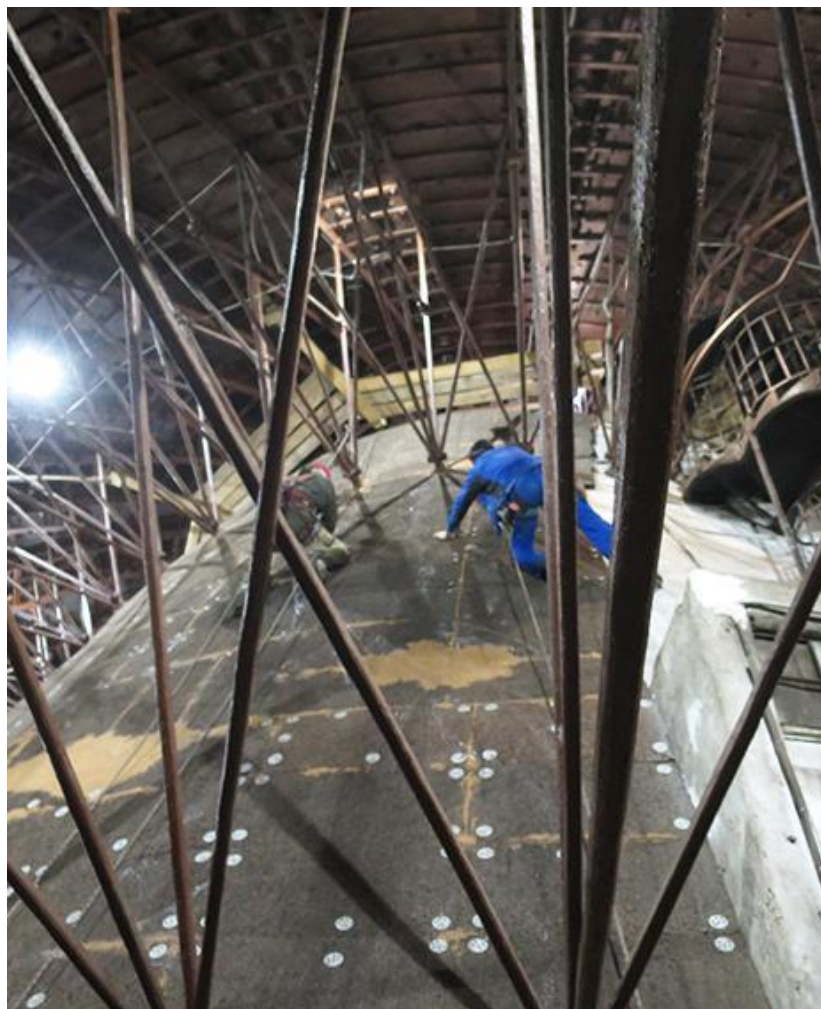
Процесс укладки дополнительного слоя пробки
