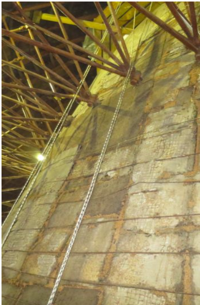
Процесс укладки дополнительного слоя пробки
