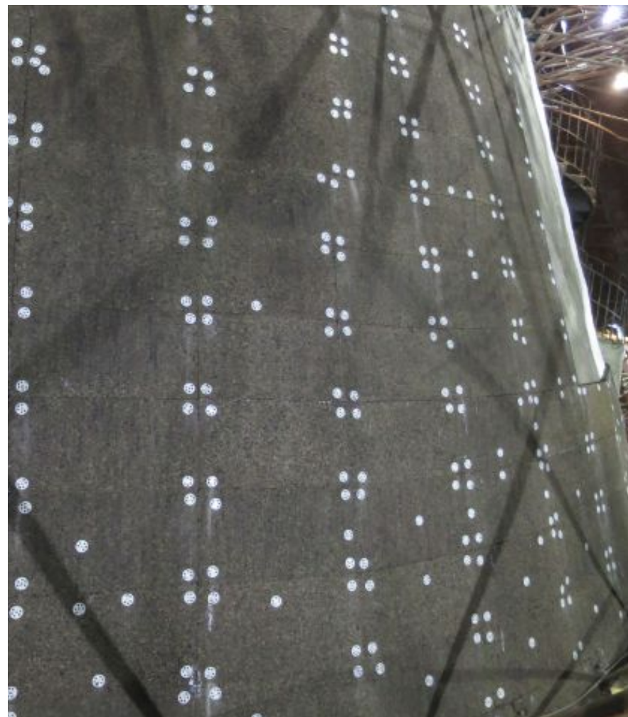
Процесс укладки дополнительного слоя пробки
