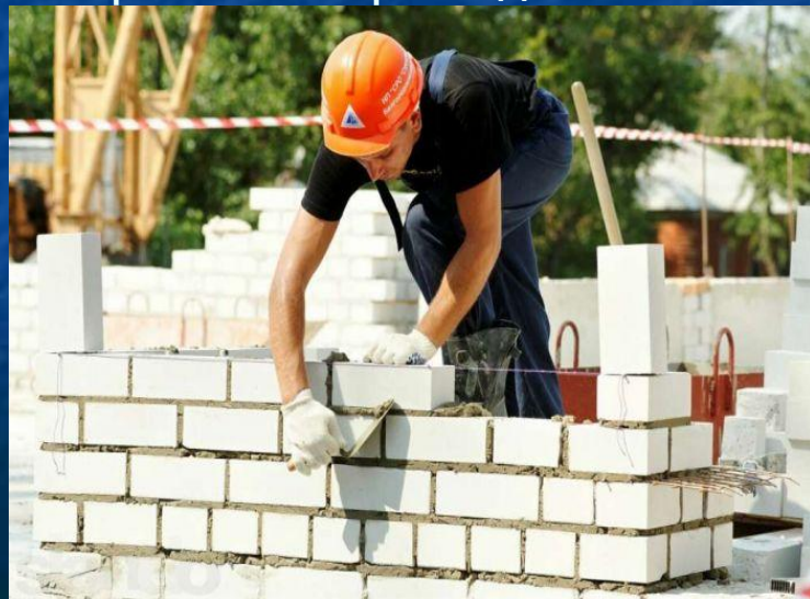
7. Строитель строит дом
