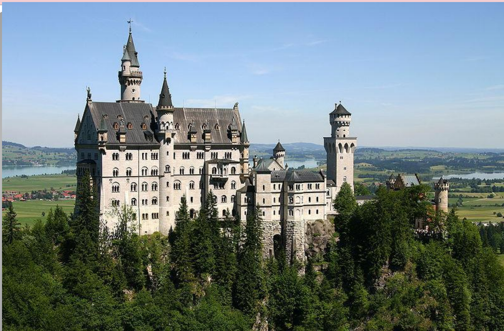
Шатровая кровля. Нойшваншейн. Бавария.
