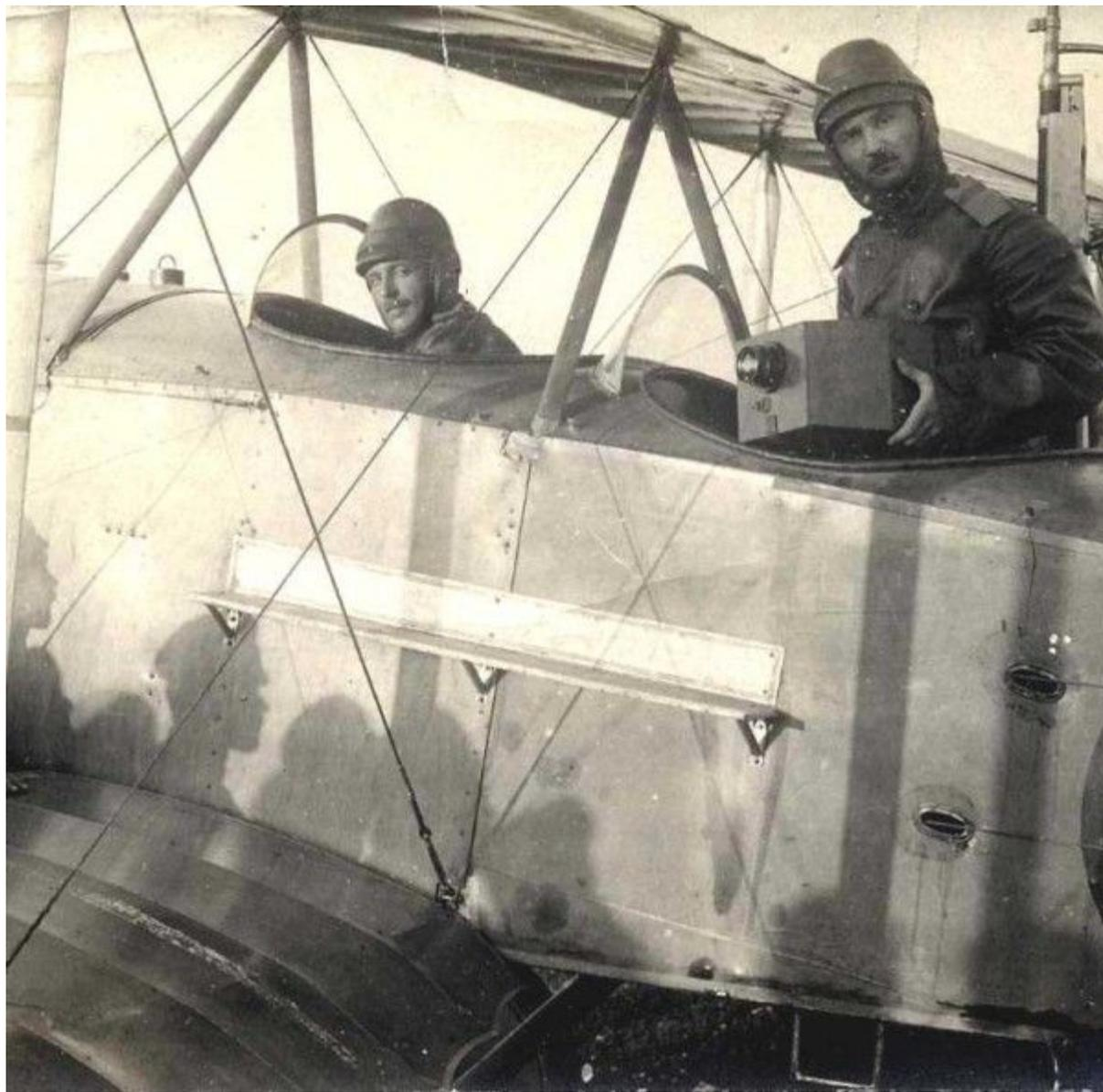
Пилоты-наблюдатели с аэрофотокамерой конструкции В.Ф. Потте
