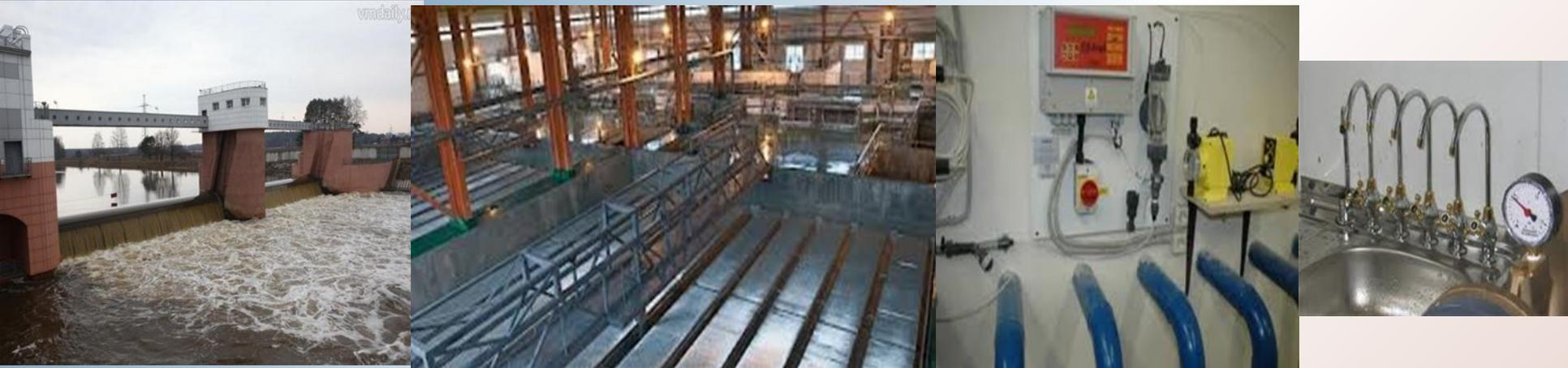
***Отбор проб при контроле стабильности технологических процессов водоподготовки.*** Для контроля различных стадий водоподготовки отбор проб следует проводить до и после соответствующей стадии (например, коагуляции, фильтрования). Отбор проб для контроля качества воды на различных стадиях водоподготовки (в том числе на входе и выходе из водоочистных устройств) проводят в соответствии с технологическим регламентом на процесс водоподготовки.
