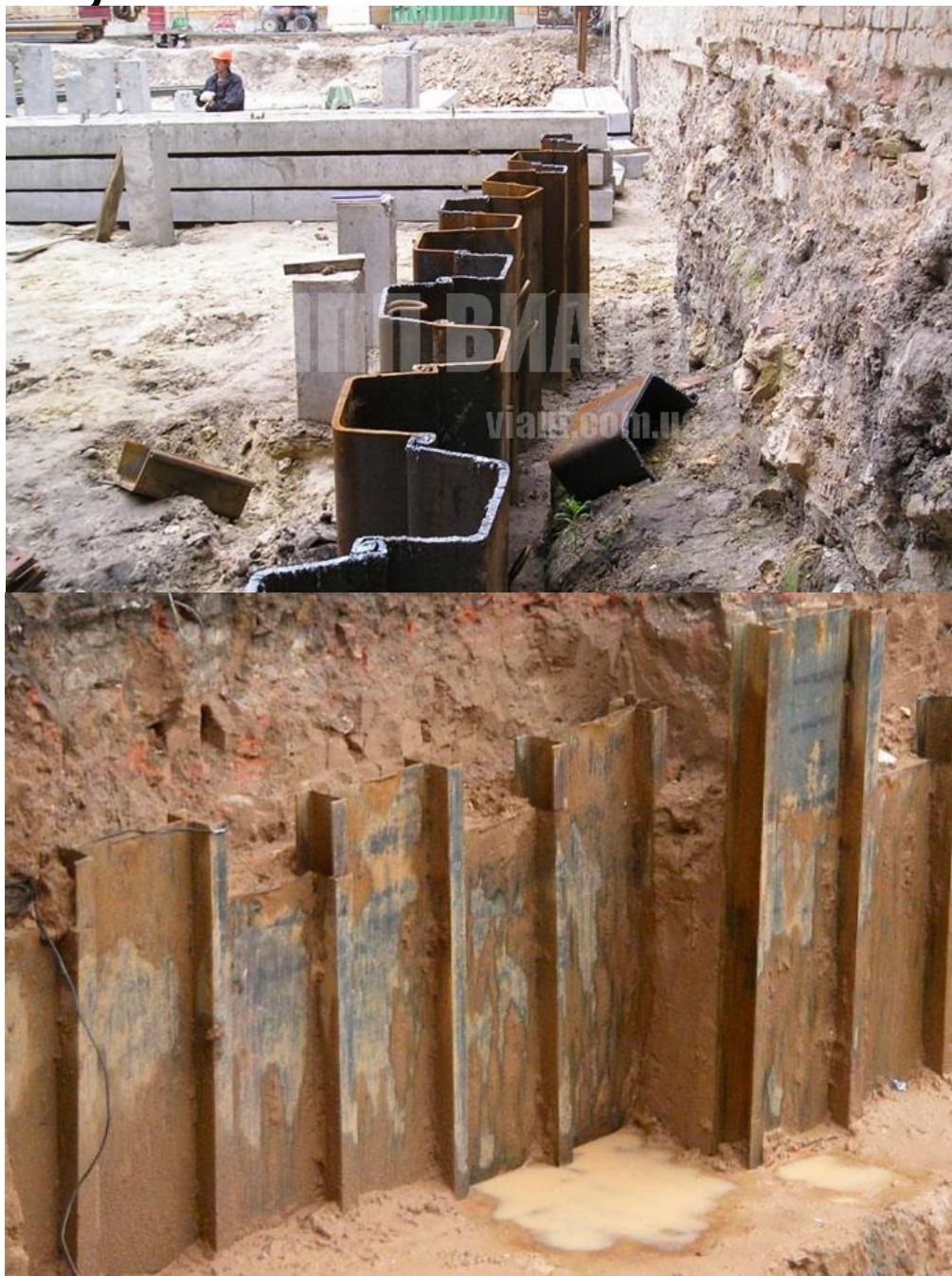
Рис. 14.4. Профили прокатного стального шпунта:
