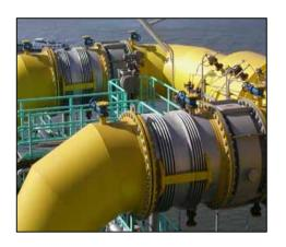
Компенсация удлинений труб производится различными устройствами, принцип действия которых можно разделить на две группы:
