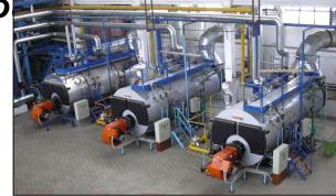
Для выработки тепловой энергии применяются котельные установки, которые подразделяют в зависимости от характера тепловых нагрузок на:
