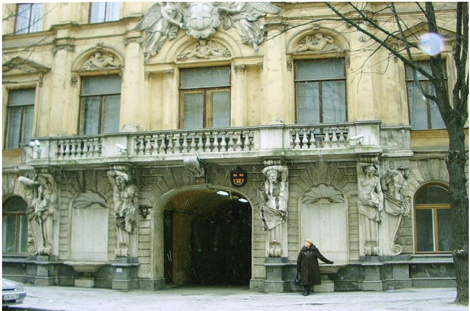
Дом купцов Демидовых на Большой Морской улице.
