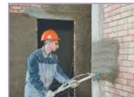
Рис. 7.6. Наружное оштукатуривание: а — работа кельмой; б — виды кельм; в — разбрызгиватель штукатурки
