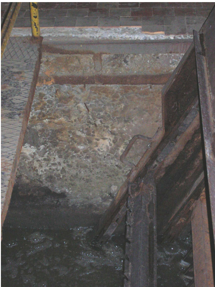
Рис. 6. Характерне пошкодження залізобетонних плит перекриття під дією водно-газового середовища
