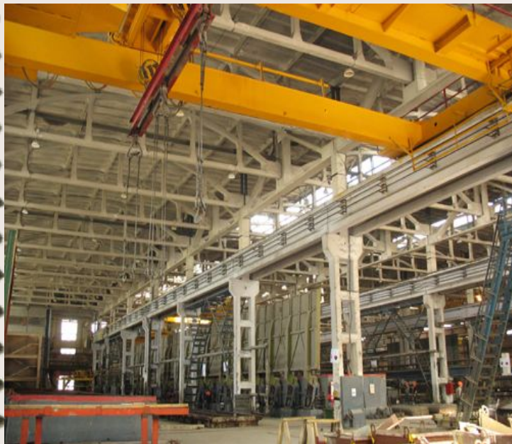
Рис.1.8. Конструктивные элементы в сборном исполнении
