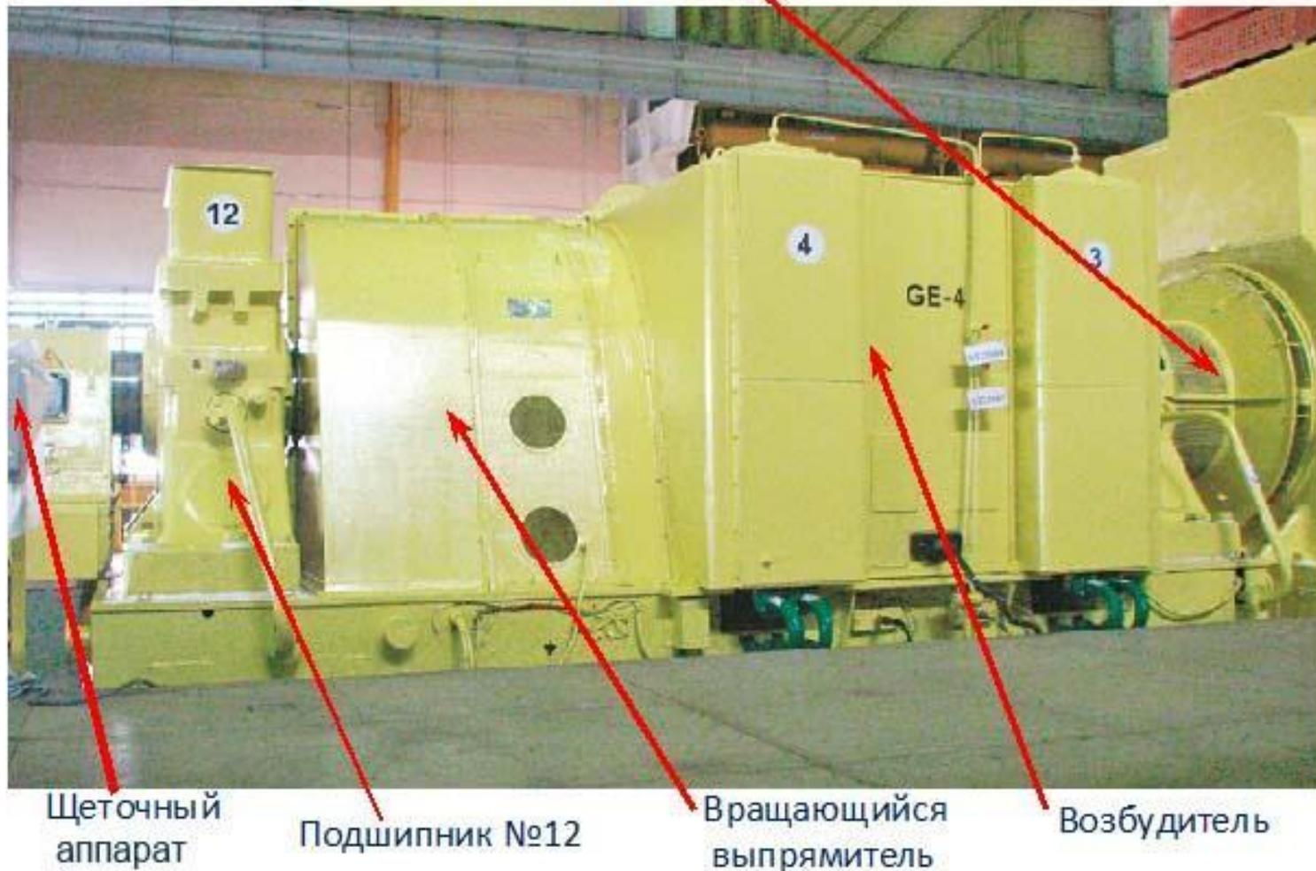
Рис. 7.8. Фото оборудования системы возбуждения СБД-470-7000-2УХЛ4 турбогенератора Запорожской АЭС в сборе
