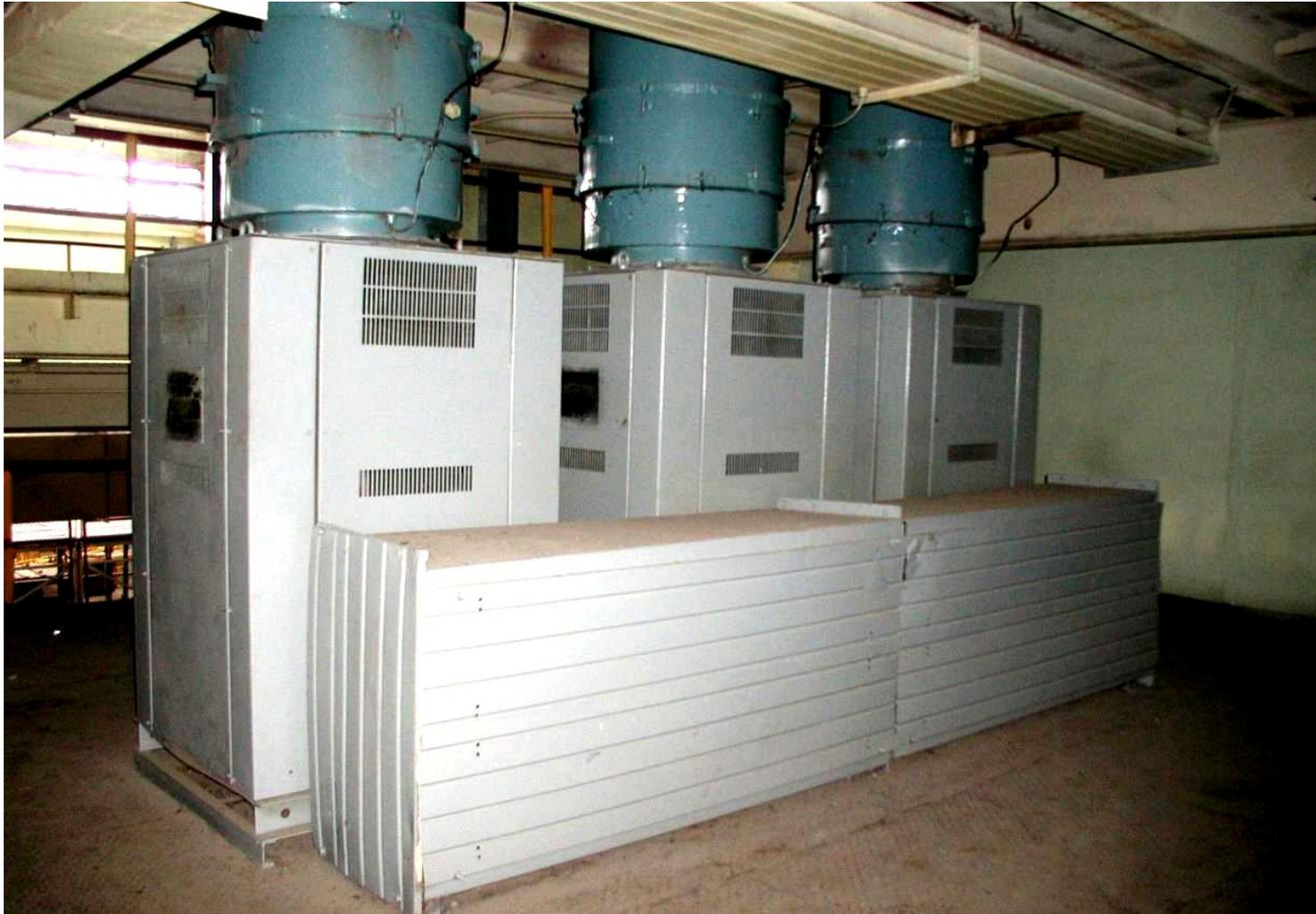
Рис. 4.4. Выпрямительный трансформатор типа ОСЗП-133/24.
