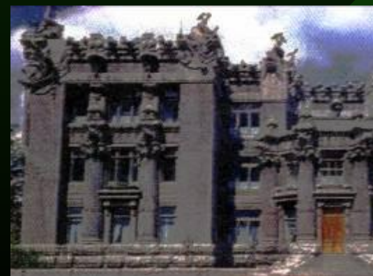
м.Київ Будинок з Химерами
