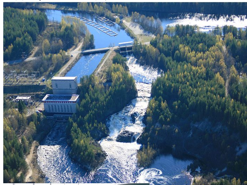
Пальезерская ГЭС. Мощность 25 МВт
