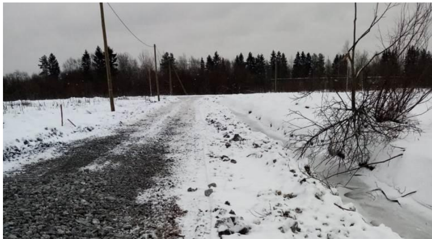
Подъезд к д. Ботово II этап (1,02 км, 3,48 млн. руб.)
