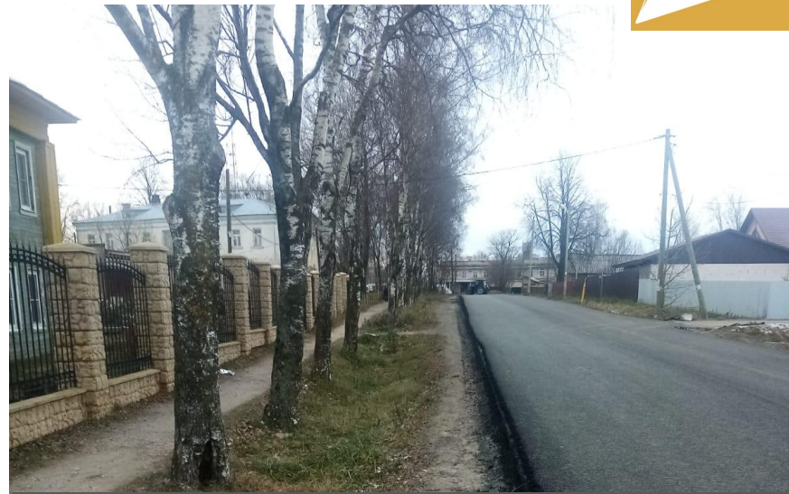
Подъезд к с. Мякса (0,7 км, 16,36 млн.руб.)
