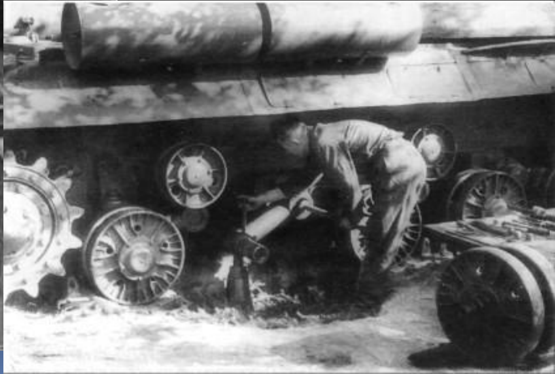
Регулювання балансиру танку ІС-3
