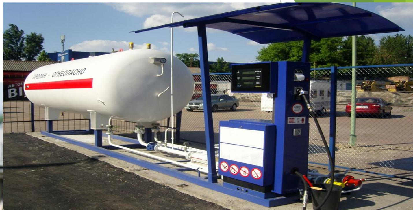
**Автомобильная газозаправочная станция (АГЗС) осуществляет заправку автомобилей и других транспортных средств, двигатели которых конвертированы или изначально рассчитаны на работу на сжиженном нефтяном газе и имеют соответствующую систему**
